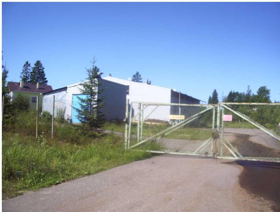
Рис. 4. Общий вид станции водоподготовки д. Агалатово (военный городок)
