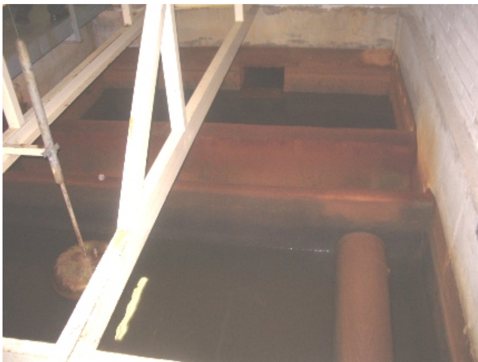
Рис. 7 Песчаный фильтр. Высота загрузки 0,8 м
